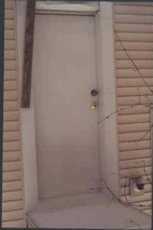
Existing Side Door
