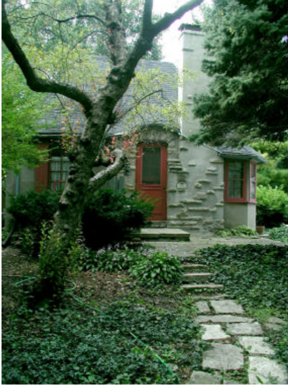
701 S. Busey East Façade
